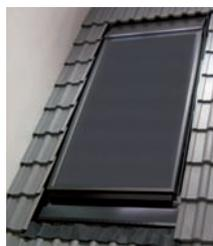
Mit Falzziegel Indach-Montage eines Flachkollektors SUN 211
